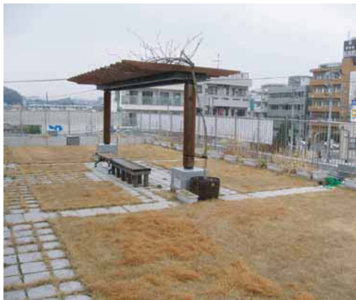
旭区庁舎2階ルーフバルコニーの屋上緑化
