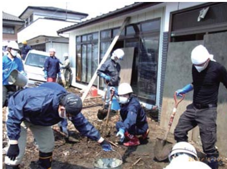
汚泥のかきだし作業（仙台市）
