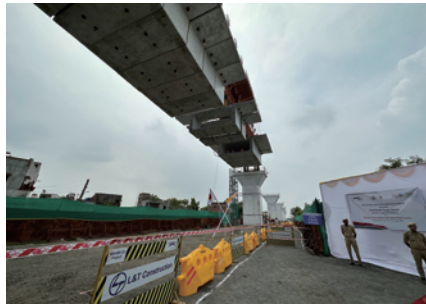
鉄道高架工事現場の様子
